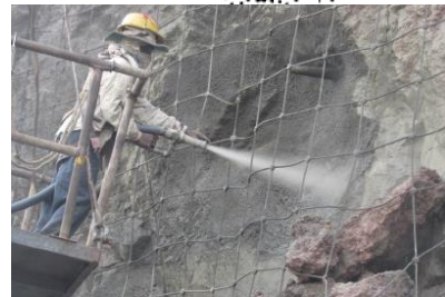
Слика 8.8: Мјере задржавања материјала на косини – површинско ојачање косине: а) мрежа са анкерима, б) торкретирање веома испуцале стијенске масе
