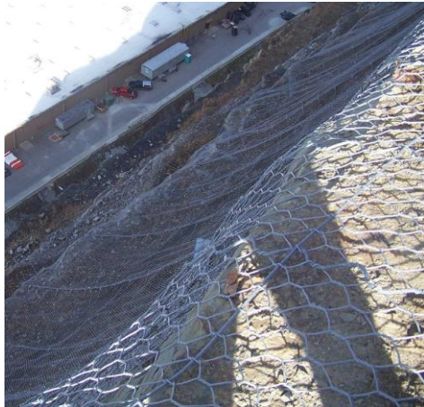
Слика 8.7: Заштитне мјере - Хексагонална двоструко уплетена путарска мрежа ојачана челичним ужадима: а) мрежа на косини, б) веза између два панела мреже
