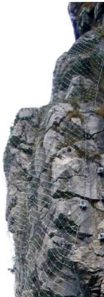
Слика 8.8: Мјере задржавања материјала на косини – површинско ојачање косине: а) мрежа са анкерима, б) торкретирање веома испуцале стијенске масе
